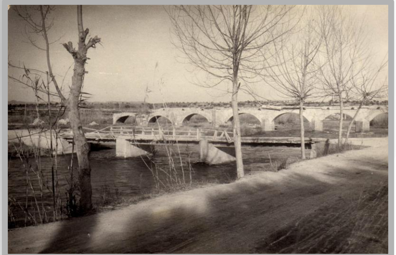
Pontón provisional hasta reparar el puente deteriorado en la gran riada del 57
